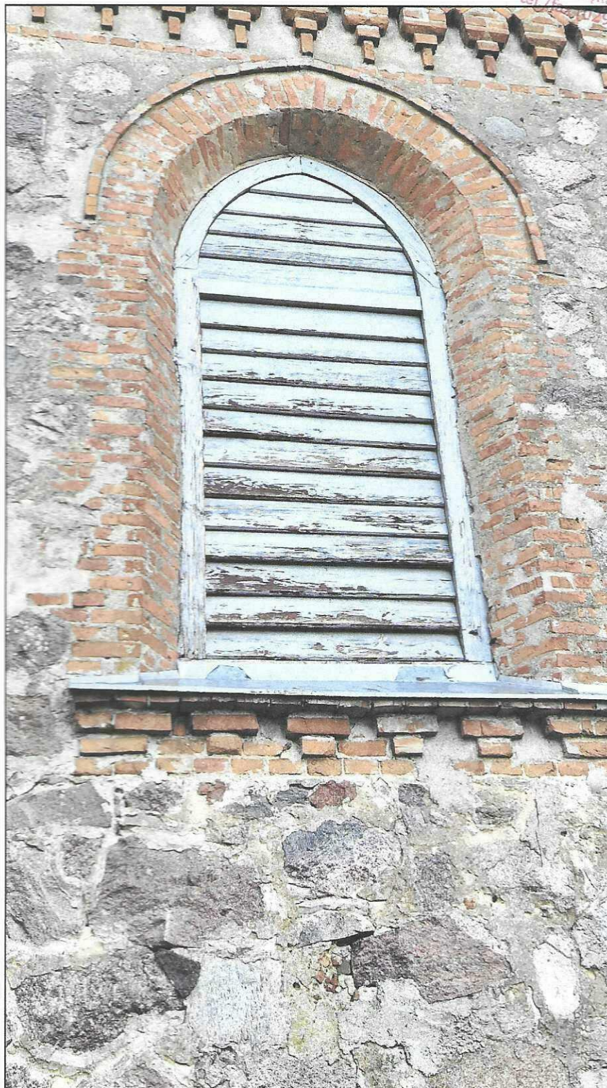
Fot.5: Piski; Dzwonnica, II poł. XVIII w.; stan obiektu przed konserwacją.
